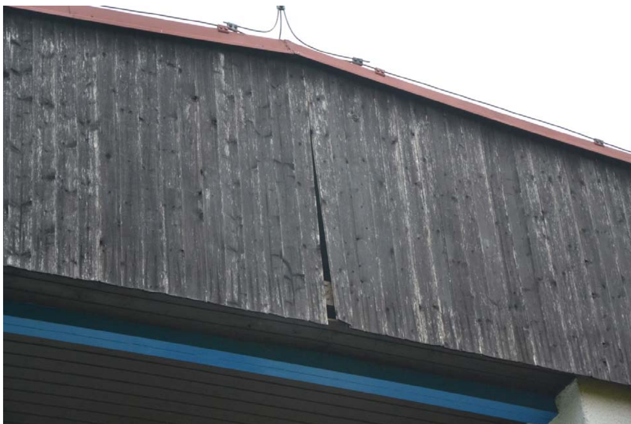
Obr 5 Poškození dřevěného obložení – příklad 3
