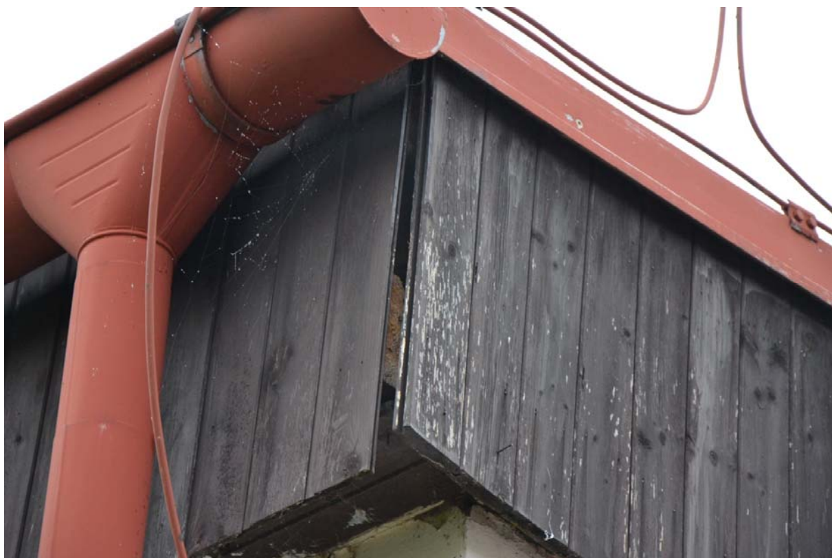
Obr 4 Poškození dřevěného obložení – příklad 2
