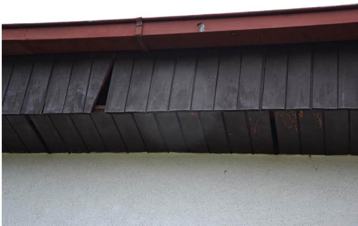
Obr 3 Poškození dřevěného obložení – příklad 1
